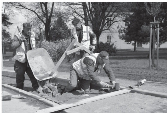
Práce na nové dlažbě před kostelem. Foto -na-
