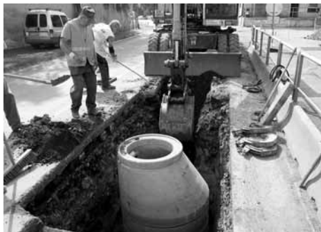
Budování kanalizace v Mělnické. Foto -fz-
