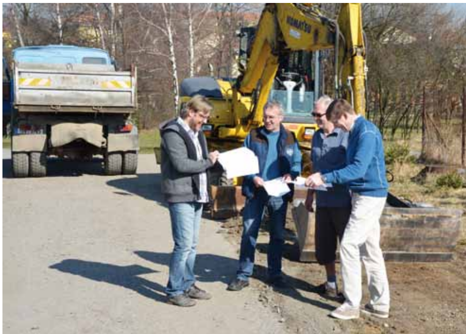
Předání staveniště ve Sportovní ulici. Foto Vít Duda
