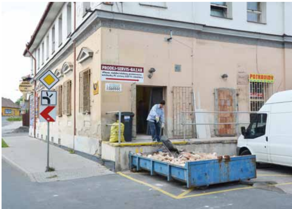
Rekonstrukce pošty začala bouráním vnitřních přiček. Foto - na-
