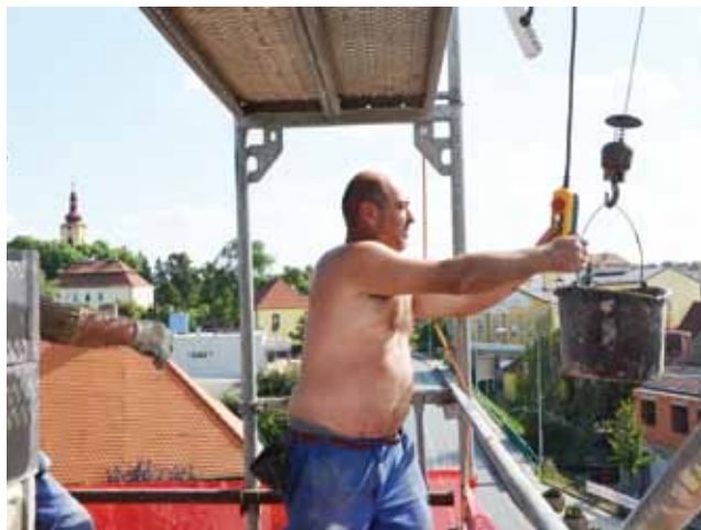
Při stavbě věže na Domě služeb. Foto –mk-
