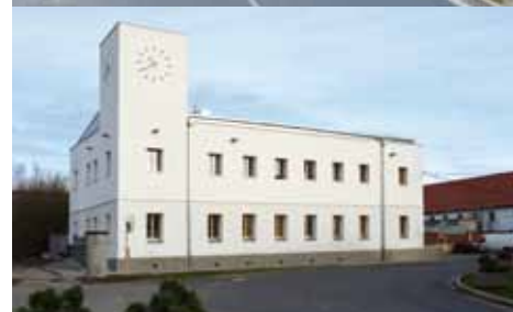
Dům služeb před a po rekonstrukci. Foto -mk-
