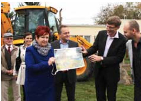
Symbolický start stavby nového pavilonu školy. Foto Václav Mikoláš
