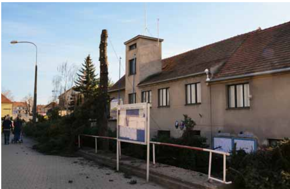
Obecní úřad – před přestavbou
