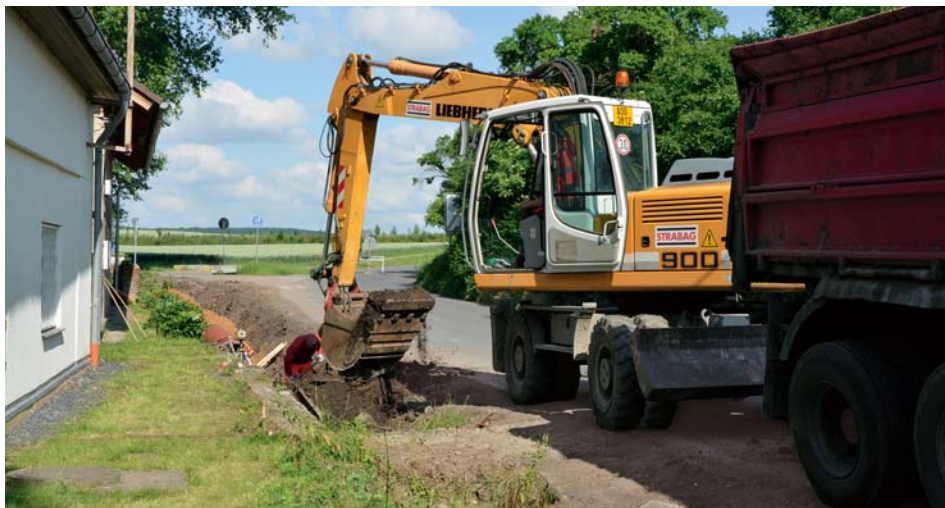
Na začátku stavby chodníku v Družstevní ulici
