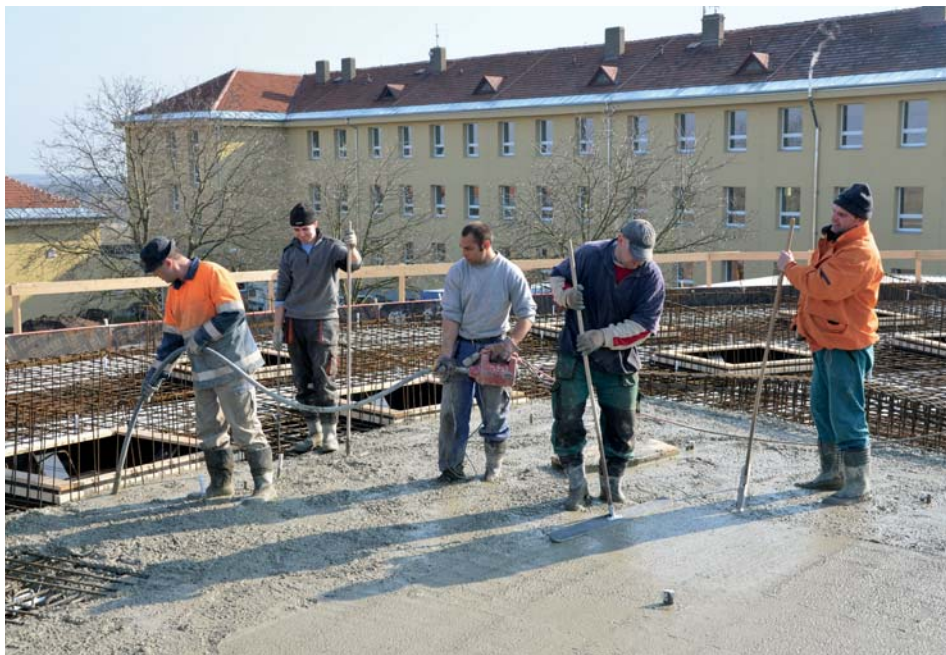
Betonování stropu Rondelu – únor 2015
