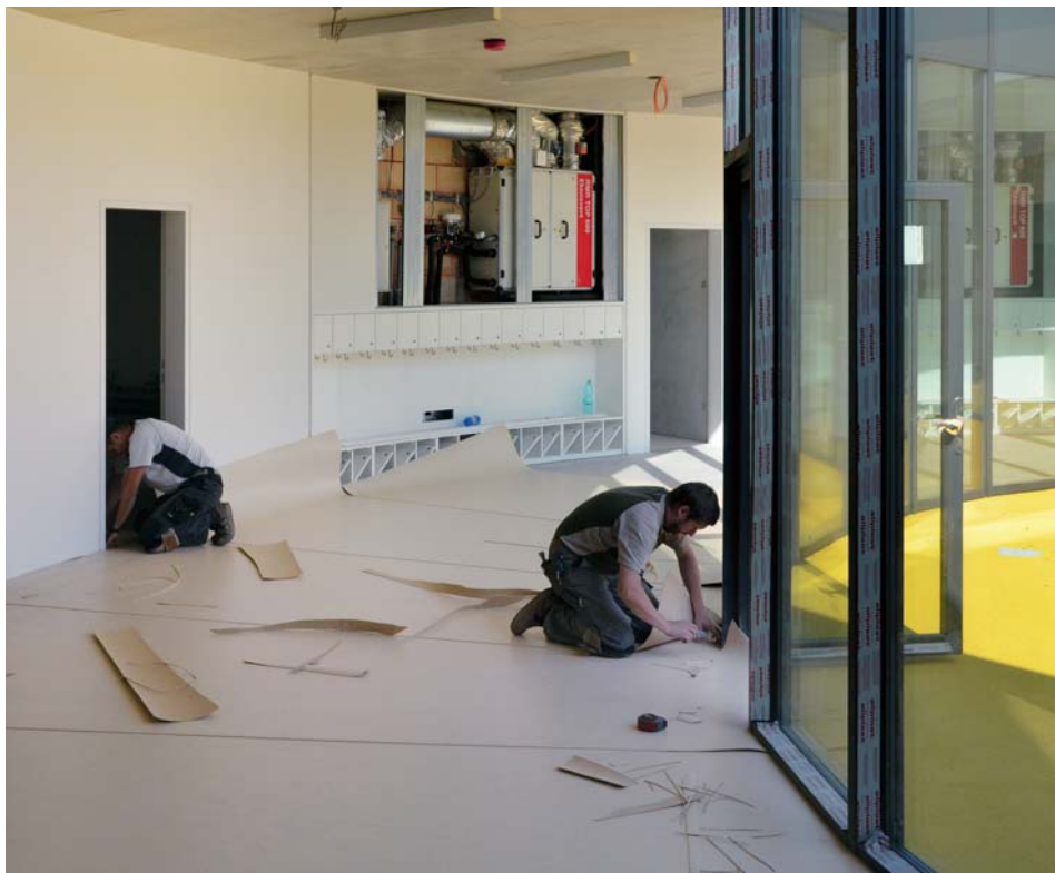
Jedna z finálních prací – položení povlakových krytin – červenec 2015
