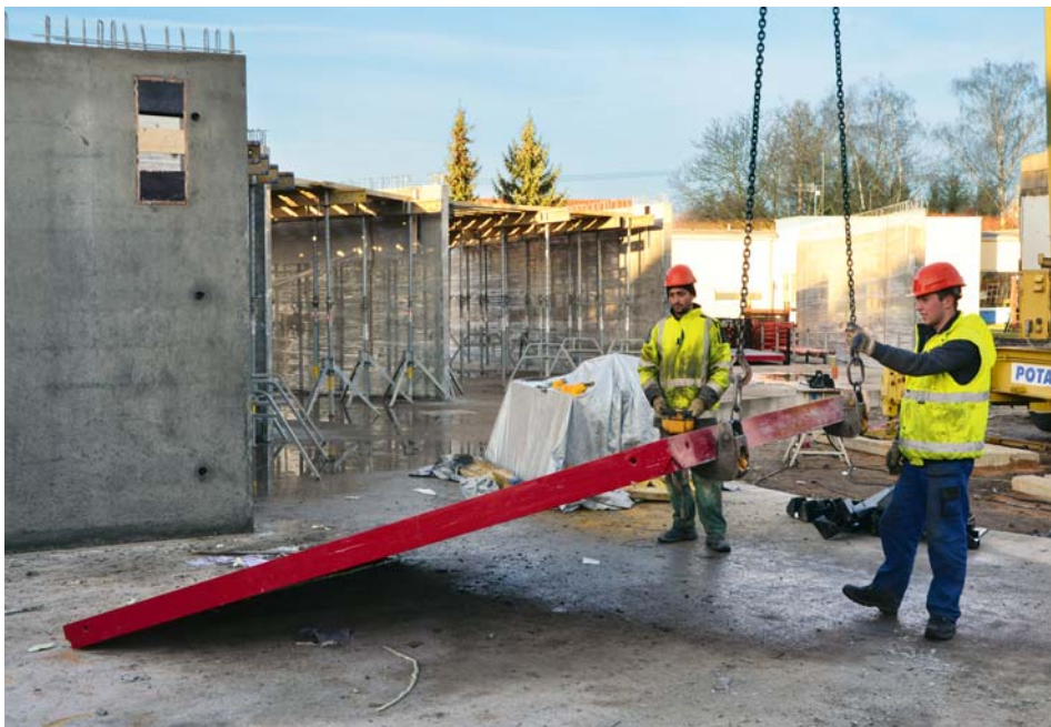
Práce na nosných příčkách z pohledového betonu
