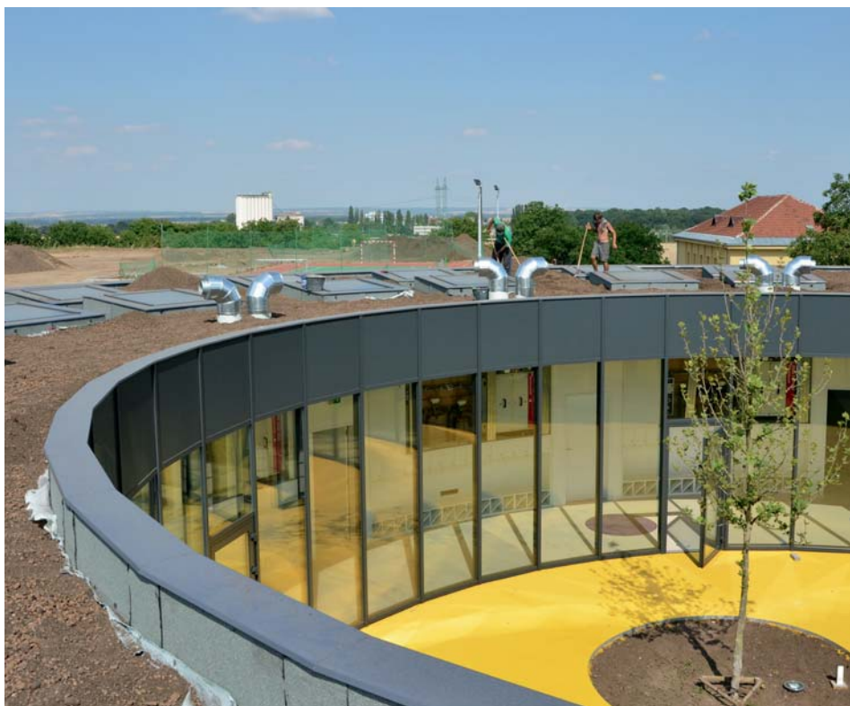
Poslední úpravy na střeše – srpen 2015
