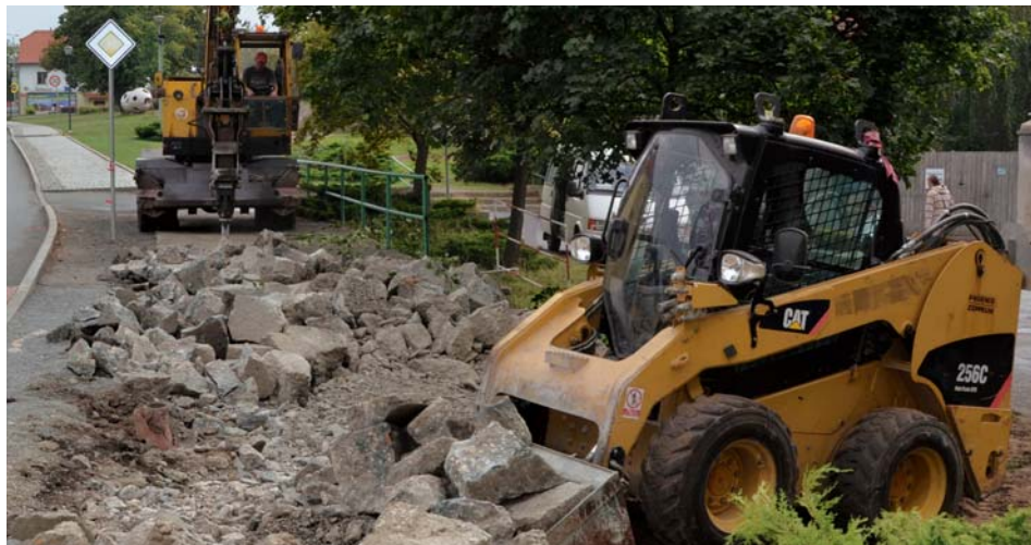
První „výkop“ k nové podobě Mírového náměstí
