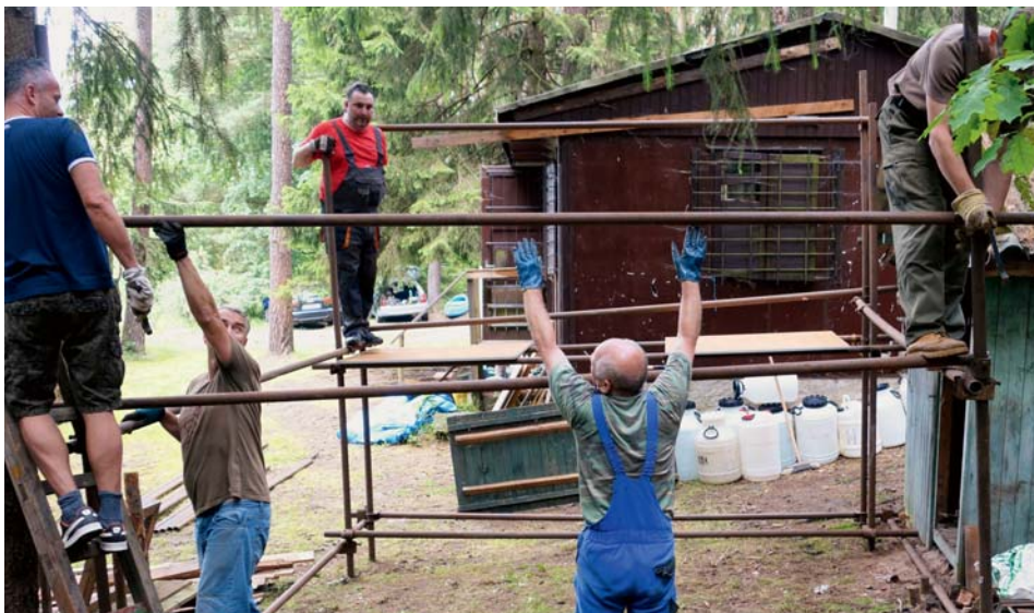
Stavba kuchyně zabere téměř celý den
