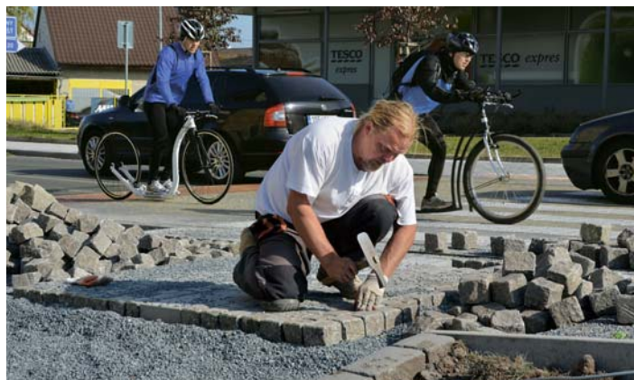
První na řadě byla výdlažba chodníku podél Mělnické
