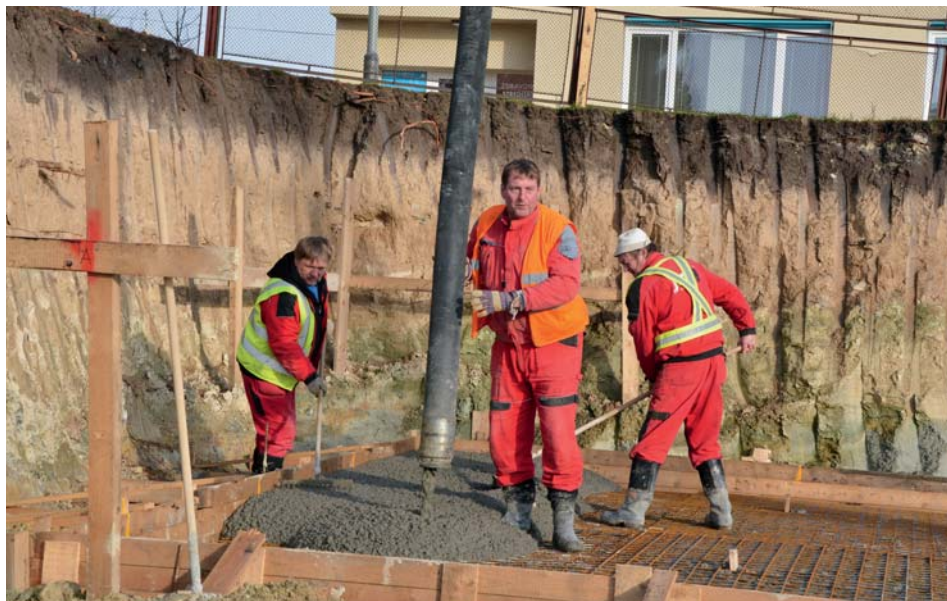
Beton pro základovou desku budovy zázemí
