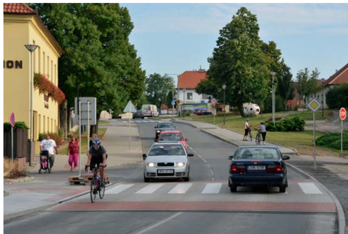
Zvýšený přechod pro chodce na náměstí
