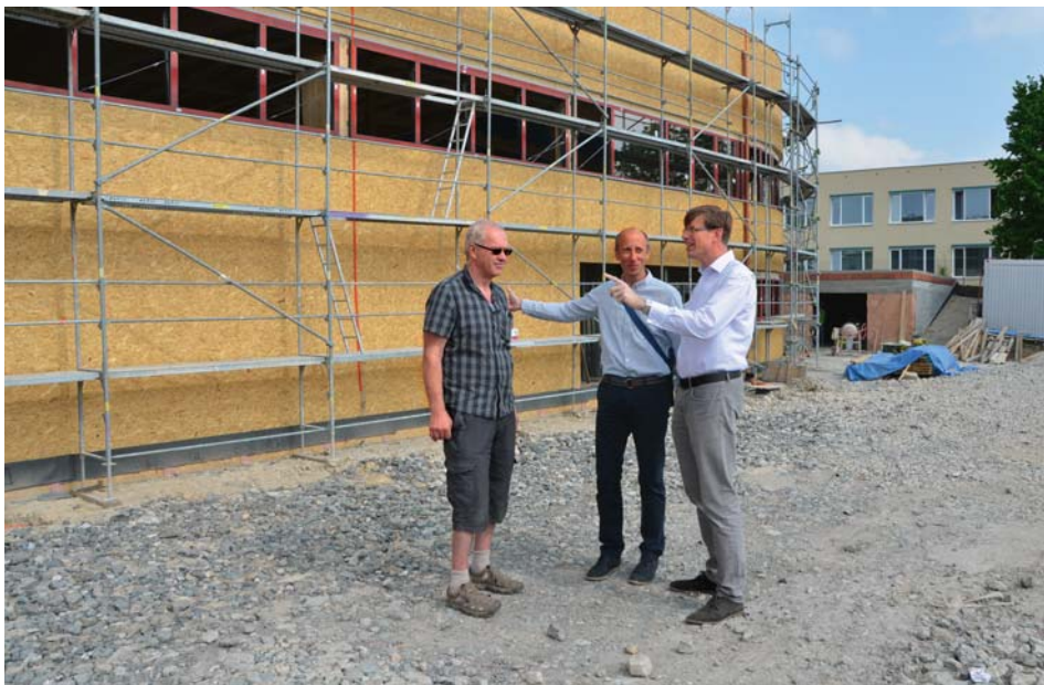
Z kontrolního dne na stavbě tělocvičny
