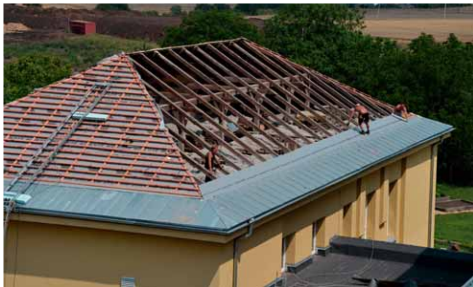
Práce začaly výměnou střešního pláště na tělocvičně
