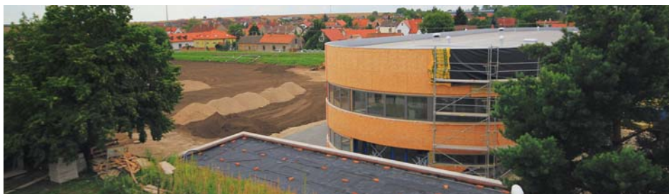
Probíhající rekonstrukce hřiště a stavba sportovní haly
