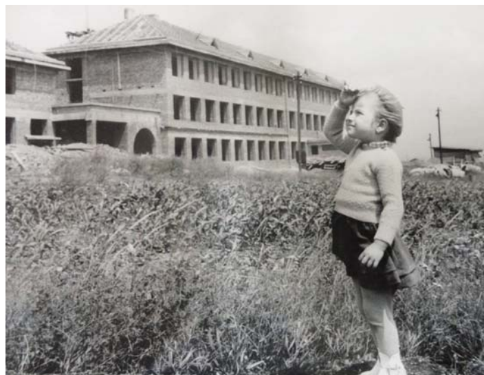
Zastřešená hrubá stavba
