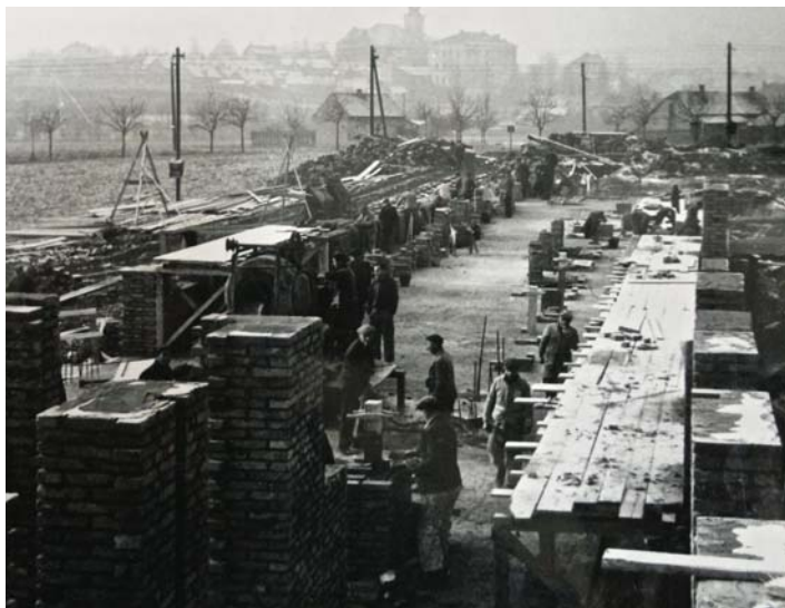
Počátek stavby školy
