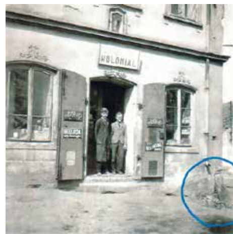
Dům čp. 89 Na Hůrce, vpravo u paty budovy ochranný patník
