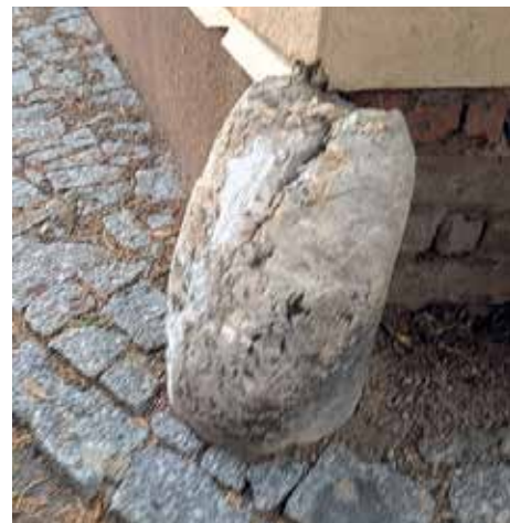
Poměrně zachovalý vjezdový patník v ulici U Kola
