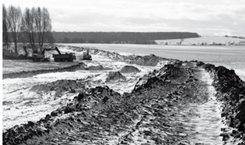
Odstranění zeminy v místě budoucího obchvatu
