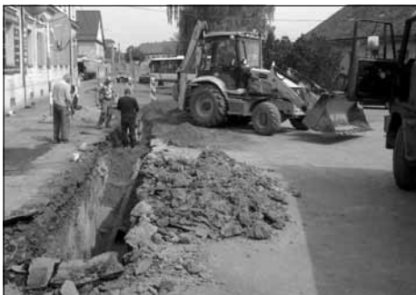
K dokončení kanalizace zbývá poslední etapa. Foto: archiv
