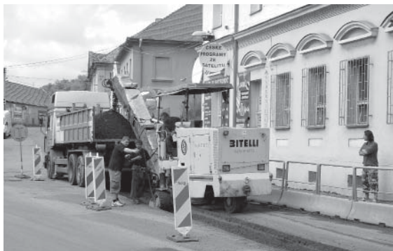
Při výstavbě kanalizace se frézovala i Mělnická ulice. Foto -fz-
