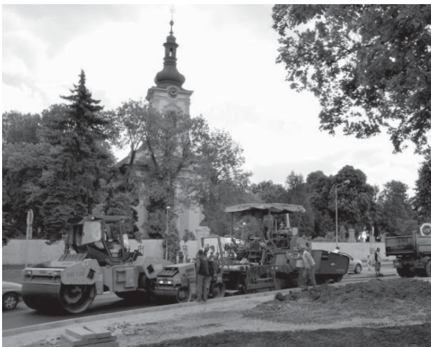
Finální práce na vozovce před kostelem. Foto -na-
