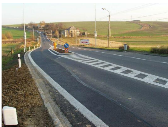
Obrázek 10 – příklad zpomalovacího ostrůvku na vjezdu do obce
