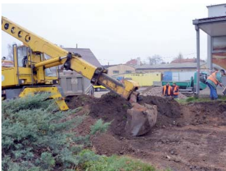
Před měsícem stavba teprve začínala. Foto -na-
