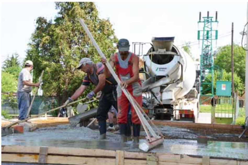
Vylévání základové desky nového traktu MŠ. Foto -na-
