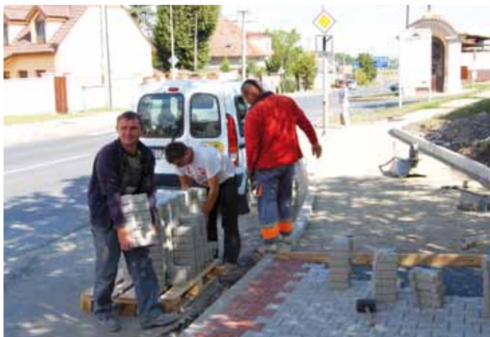
Práce na zastávce Líbeznice II. Foto -na-
