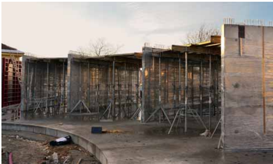
Foto 1 – Dokončení všech příčných nosných zdí
