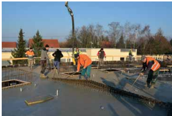
Foto 7 – Rondel je kompletně zastřešen
