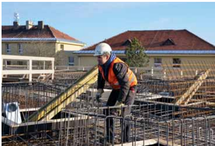
Foto 6 – Střecha dostala ocelovou výztuž
