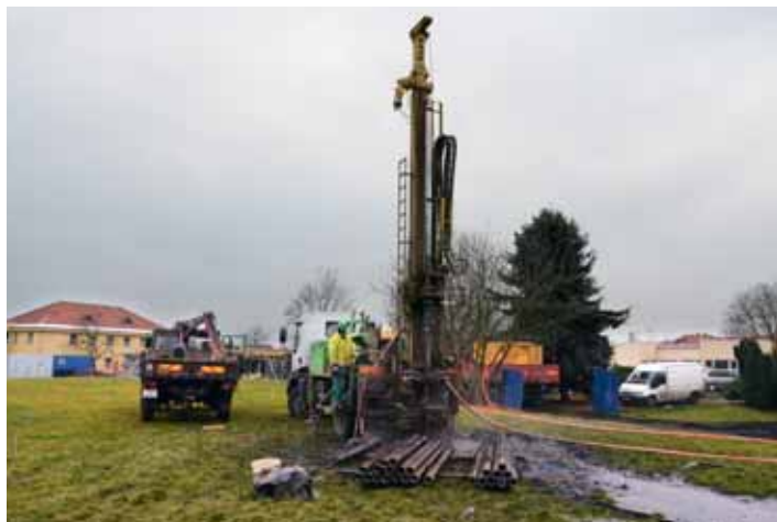
Foto 3 – Práce na geotermálních vrtech
