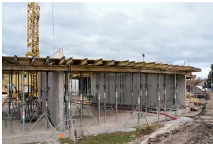
Foto 2 – Výstavba Rondelu pokročila ke stropu a střeše
