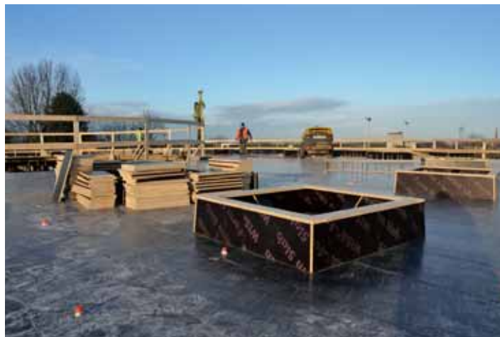
Foto 5 – Práce na střeše Rondelu
