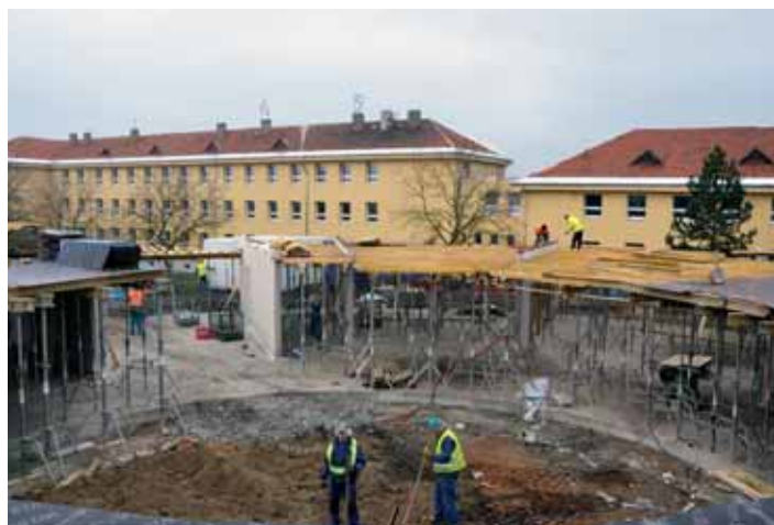
Foto 4 – Jeřáb opustil střed budoucího atria
