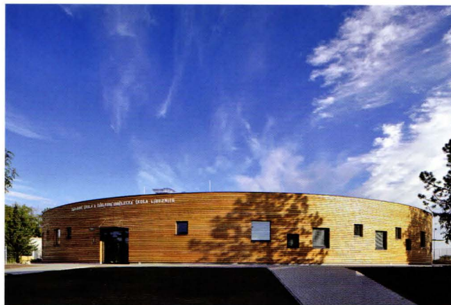
2 Hlavní vstup je orientován do předprostoru školního areálu s autobusovou zastávkou.
