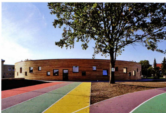
3 Únikový východ v jedné z učeben směřuje na sportovní hřiště v horní části školního areálu.
