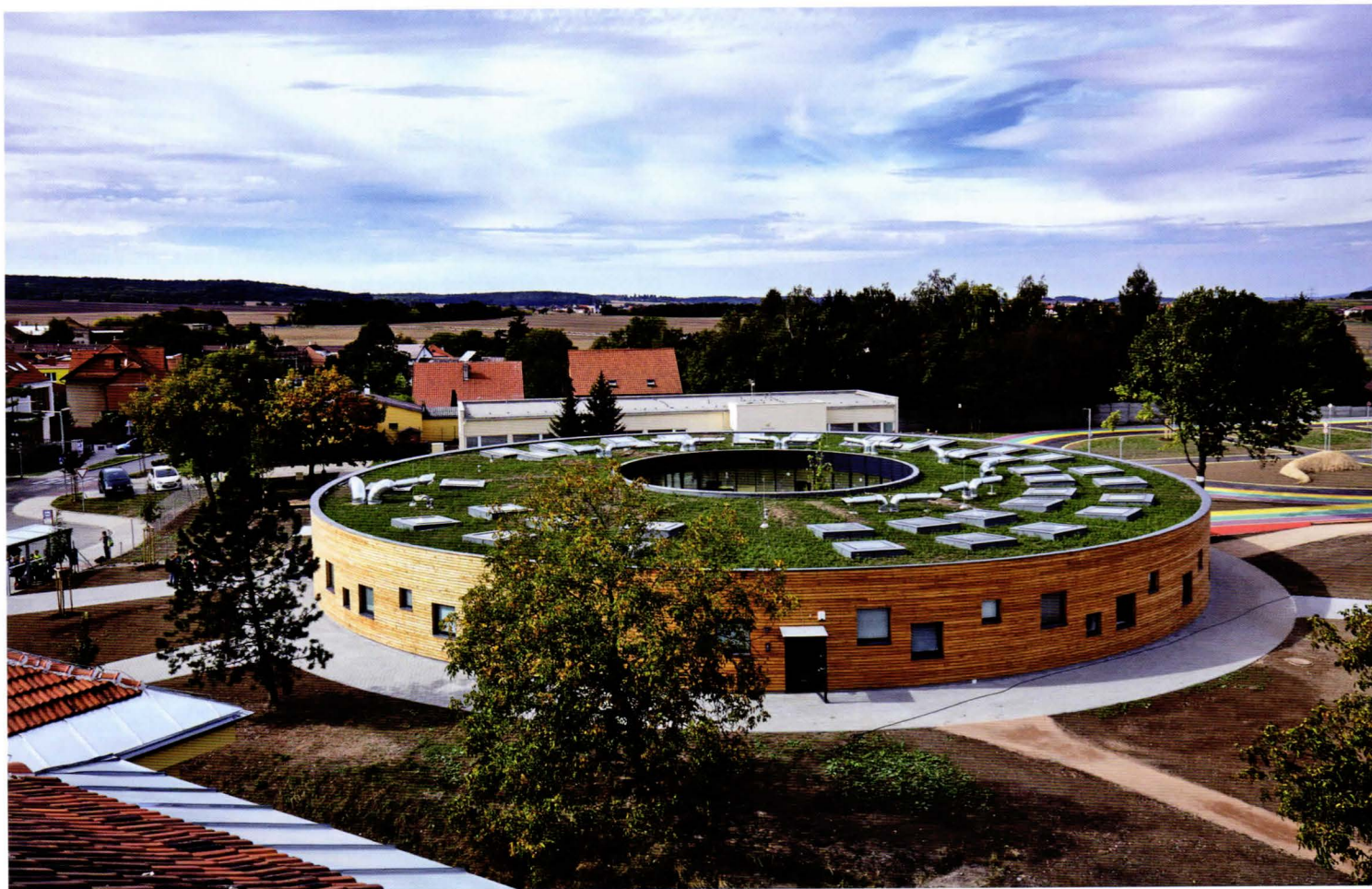
1 Pavilon základní školy v Líbeznicích u Prahy je určen pro 240 dětí v osmi kmenových učebnách; vnější fasáda rondelu je zděná s obkladem z nehoblovaných modřínových prken a nepravidelně rozmístěnými okenními otvory, fasáda do atria je celoprosklená.
