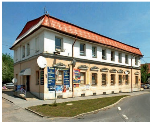
Libeznice, Dům služeb, stav před rekonstrukcí
