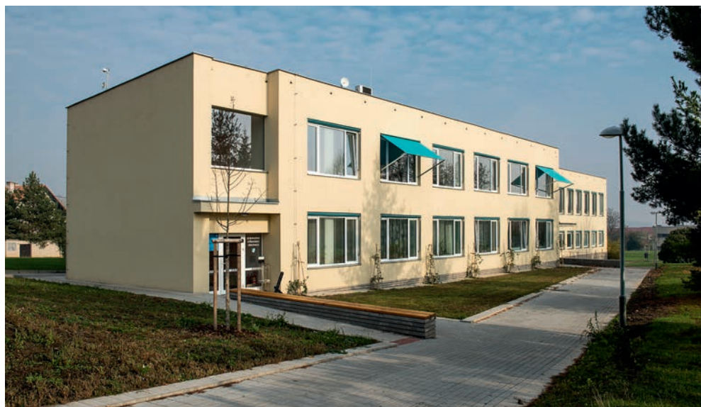
Ateliér M1 architekti, architektonická úprava zateplení fasád polikliniky, realizace. Foto Petra Hajská
