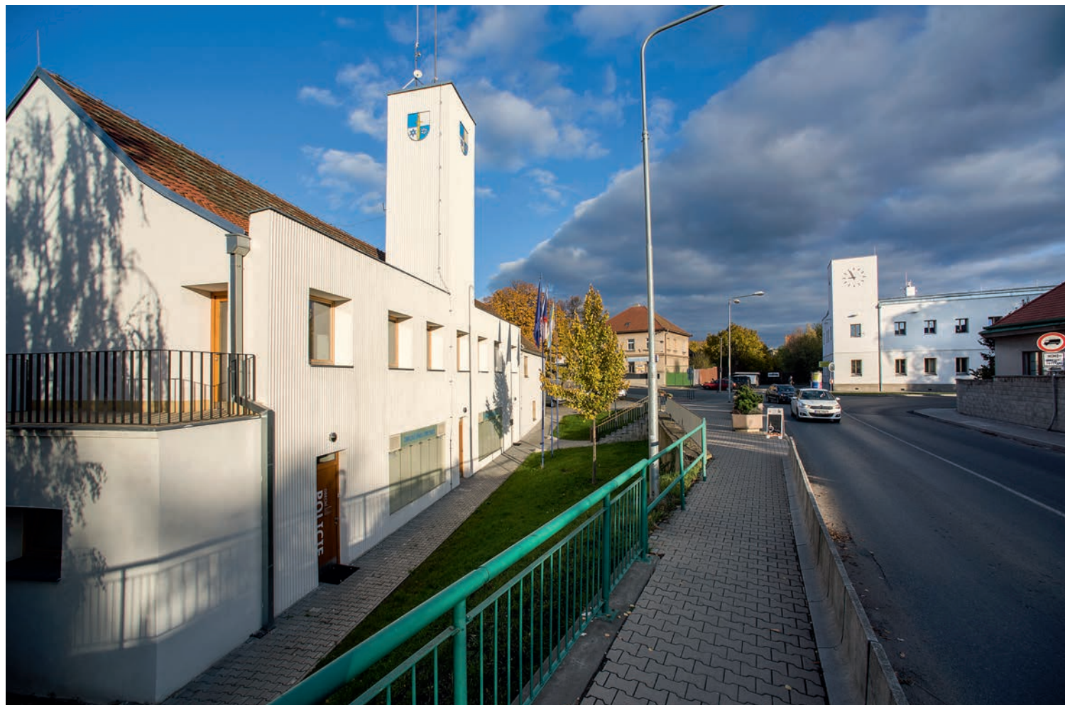
Radnice a dům služeb po zateplení fasád. Foto Petra Hajská
