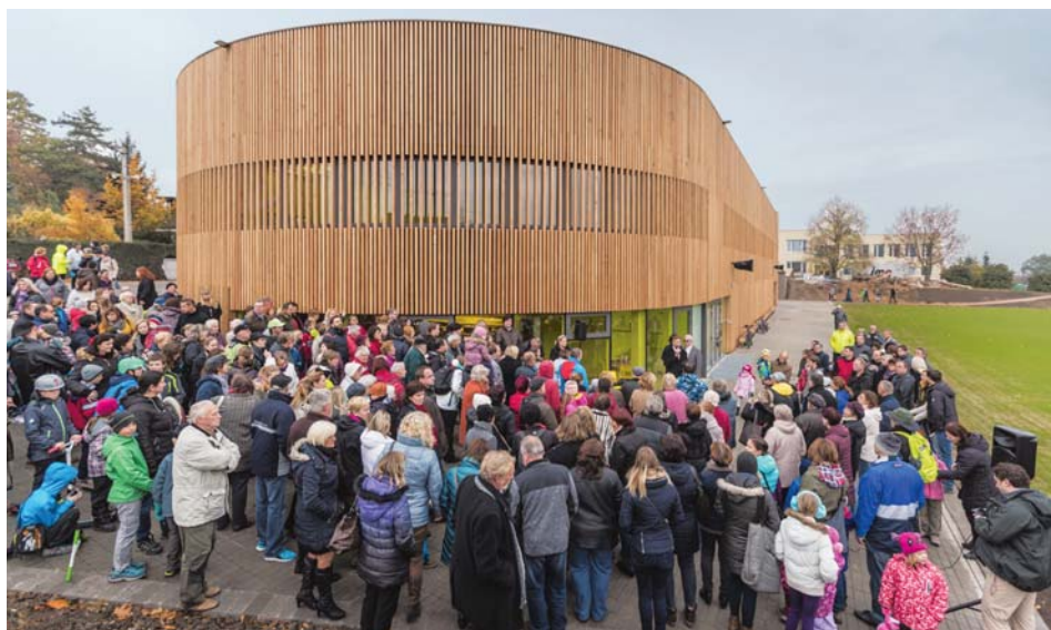
Nově otevřená tělocvična a multifunkční společenské centrum Na Chrupavce
