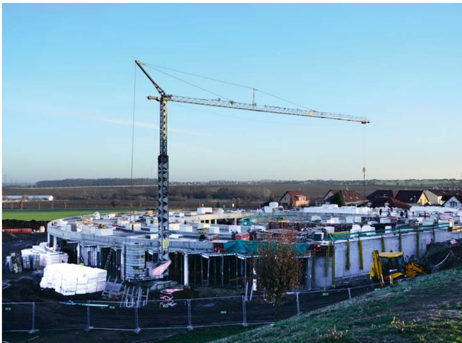
Nová budova školy – neorondel
