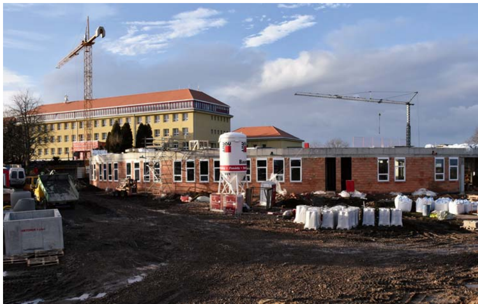
Staveniště nového Rondelu
