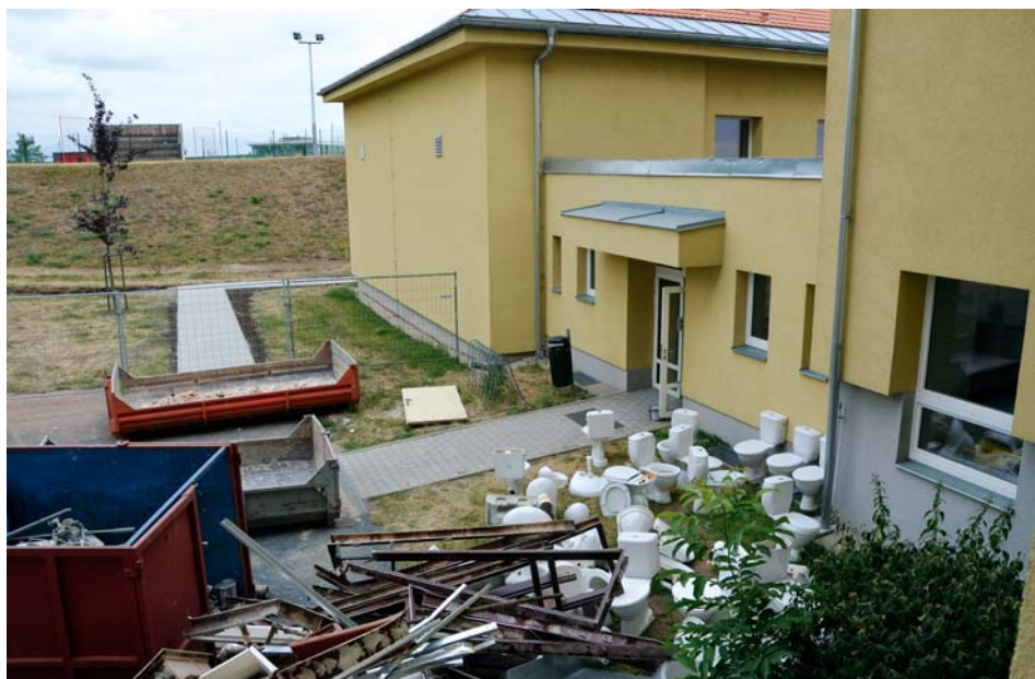
Rekonstrukce školy začala
