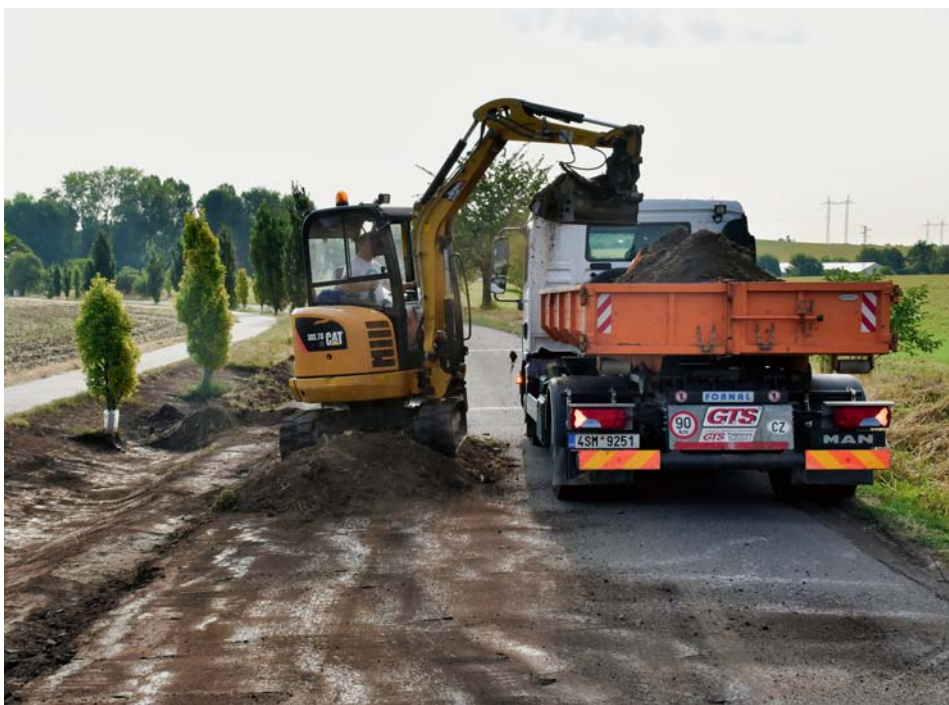
Ulice Měšická v době rekonstrukce
