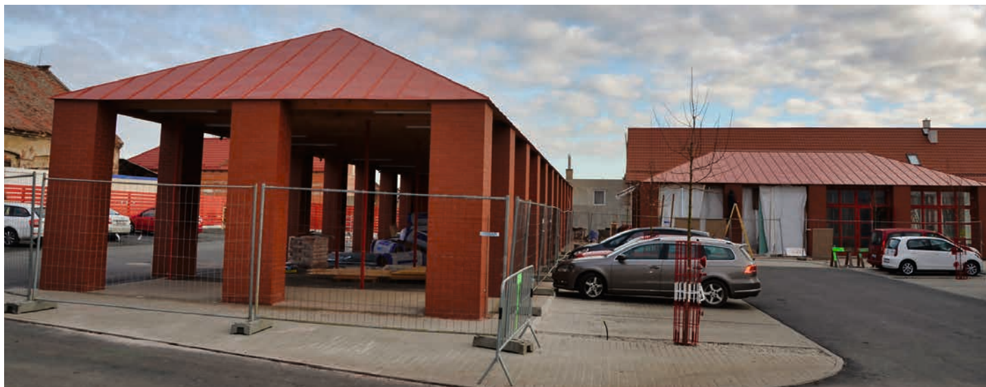
Nová hasičská zbrojnice a zázemí technických služeb, stav stavby v prosinci 2019
