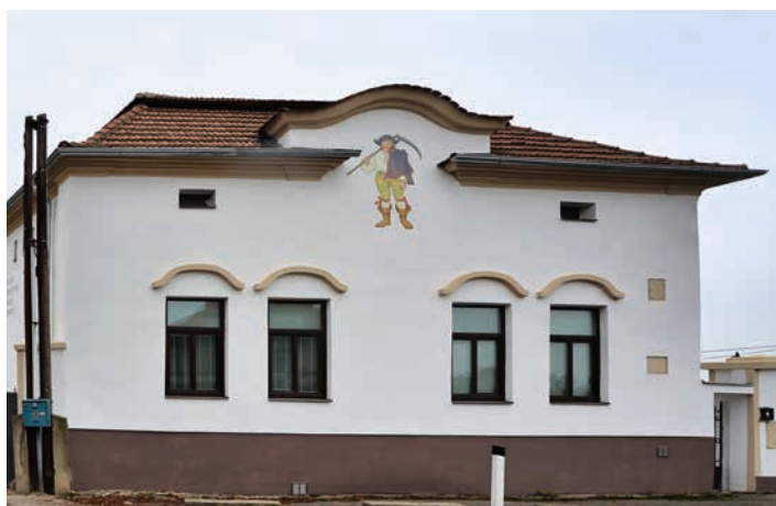
Nové průčelí včetně figurální výzdoby na statku čp. 38
