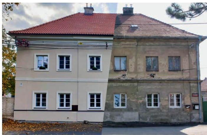
Podoba průčelí statku v ulici U Studánky před rekonstrukcí a po ní foto -vs-
