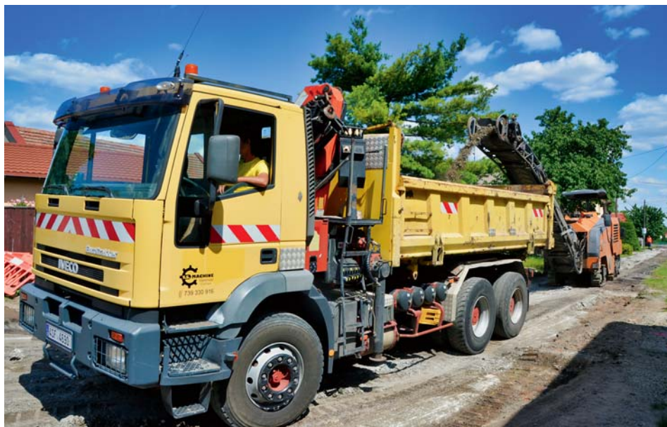
Fréza v plné práci na ulici K. H. Máchy
