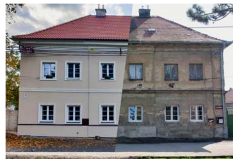
Oceněná rekonstrukce průčelí v roce 2019
