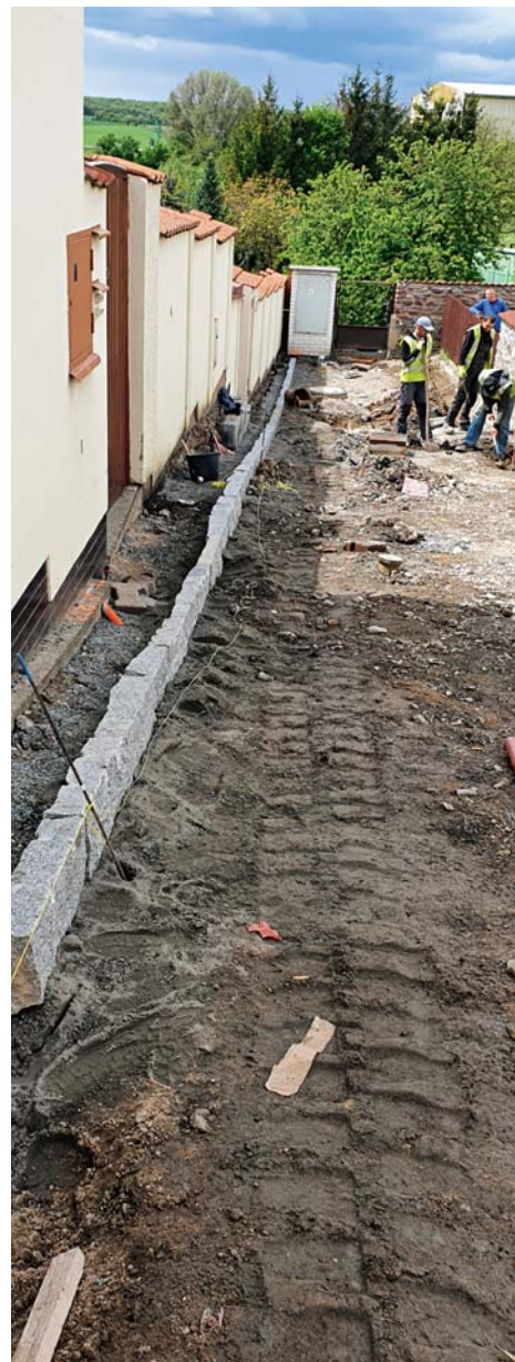
Stavební práce v ulici Na Skalce foto archiv obec
