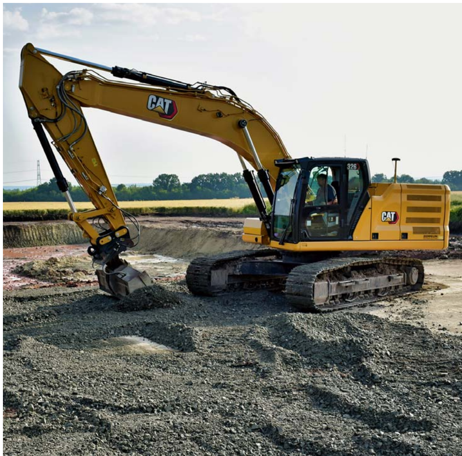
Nově budovaný zemní vodojem nedaleko křižovatky U Papryčů
