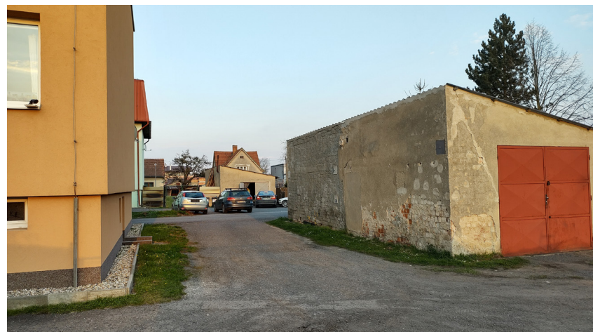
Garáže a kůlny
