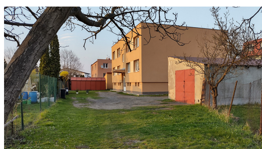
Pohled od jihu - neformální vstup do území, který je zjevně využíván jako vjezd ke garáži
