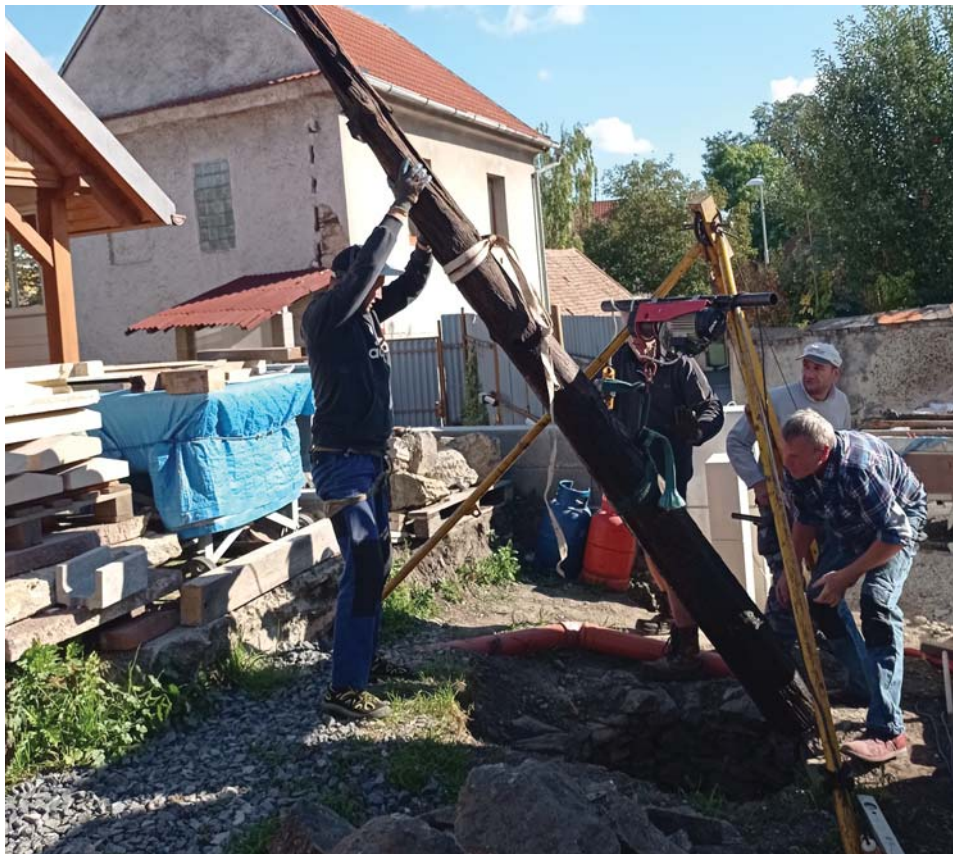
Vyjmutí dřevěného čerpacího zařízení ze studny v čp. 56
