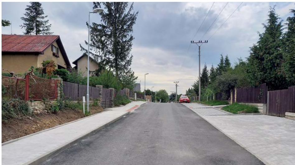
Pakoměřická ulice po rekonstrukci
