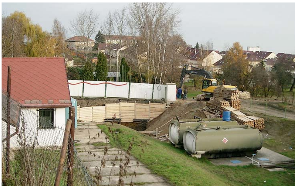
Stavba čistírny odpadních vod
