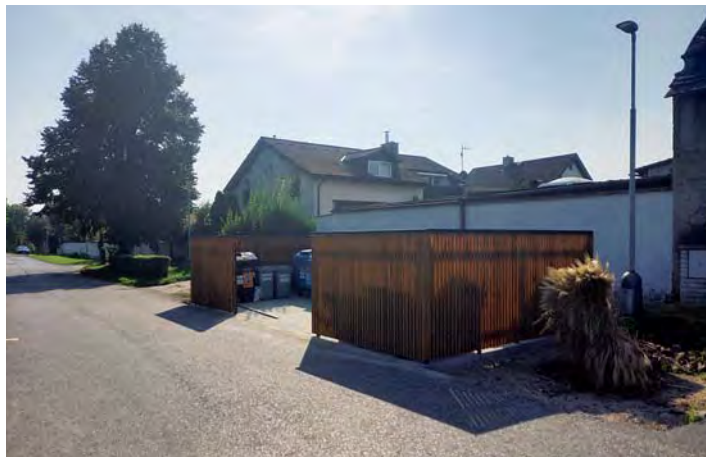
Kontejnerové stání v ulici Na Mýtě v moderním kabátě
