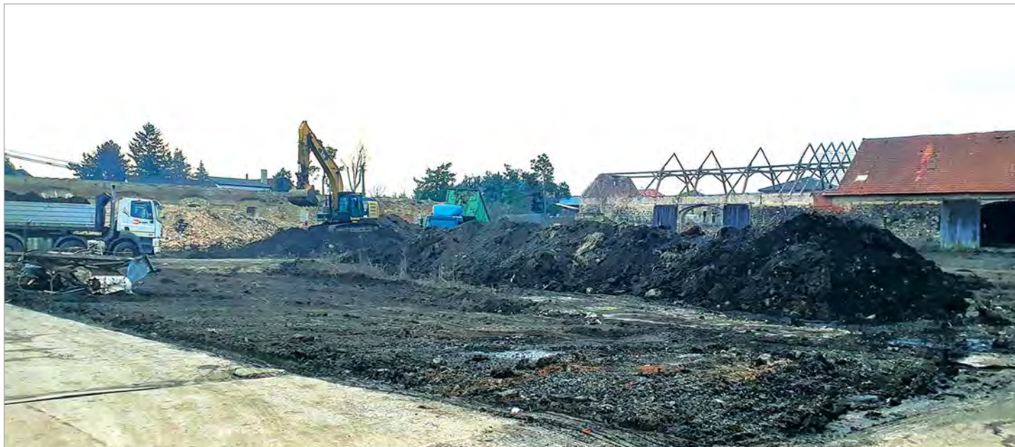
Stavba školy začala bouráním
