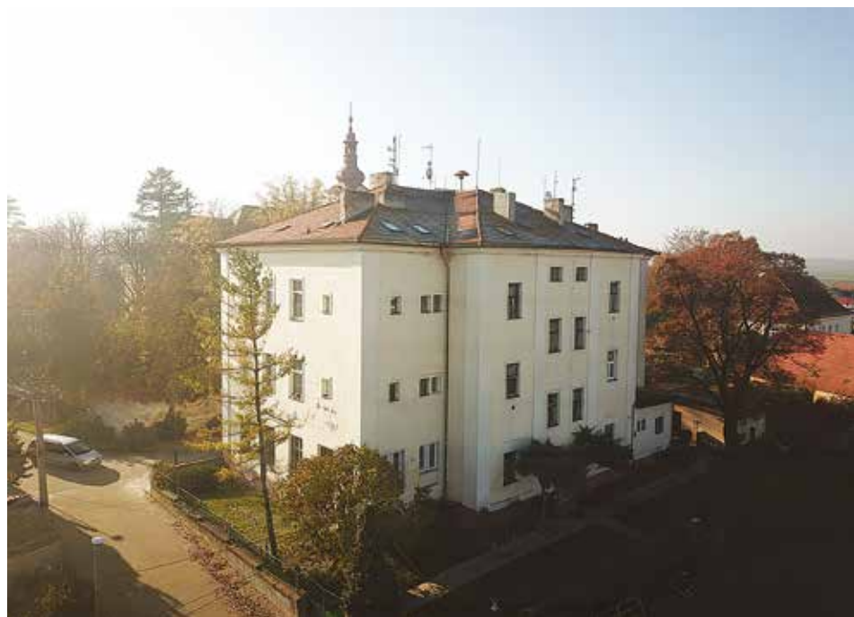
I budova staré školy čp. 142 sloužila jako zdravotní středisko
